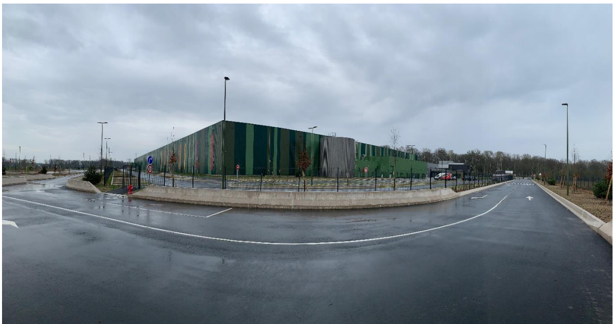
Vue du site en direction du Nord Est.
