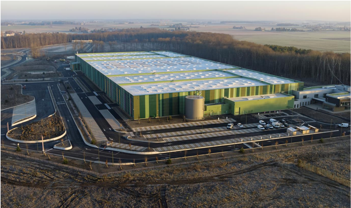
Vue aérienne du site en direction du Nord Est.
